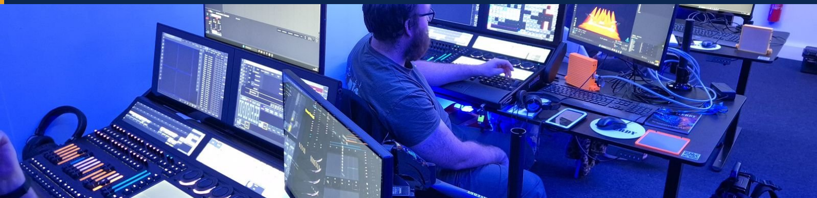
Centre Oliverdy — formation grandMA3 sur consoles Light et compact XT dédiées pour le niveau 3
