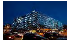
Façade de la DI
